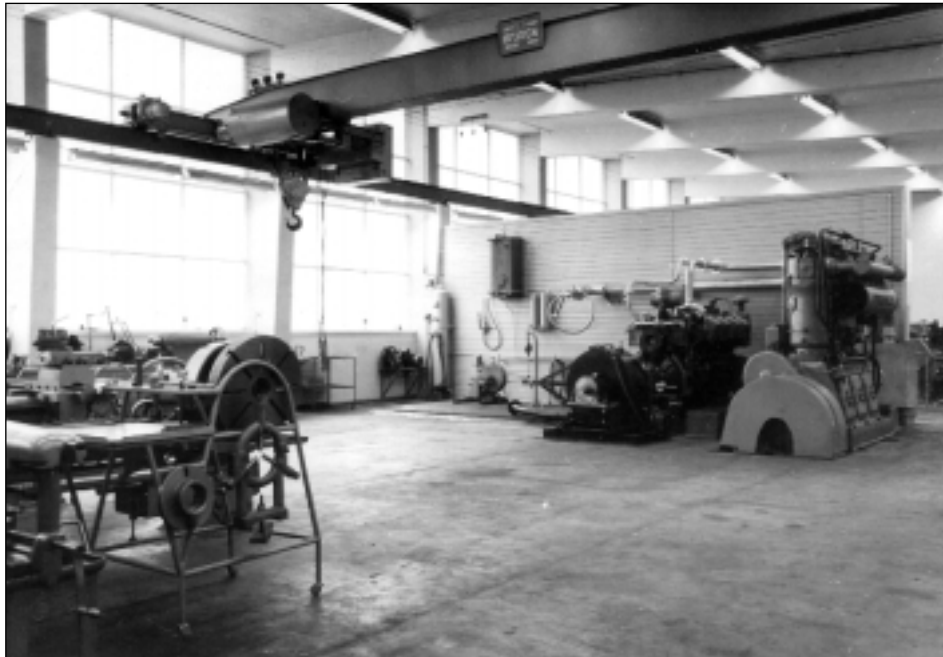
Interiøret i motormekanikarbygget i 1964. I dag verkstad for grunnkurs mekaniske fag.
