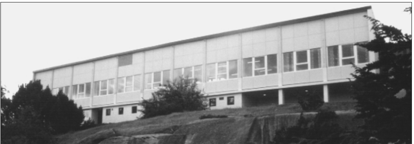
Bygg for plate, sveis og røyr tatt i bruk i 1973. I dag brukt til maritim opplæring.
